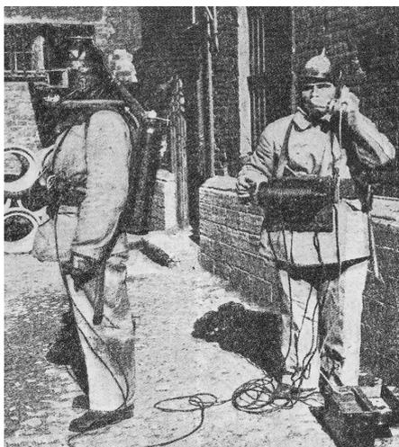
Рис. 5. Дыхательный аппарат на сжатом воздухе инженера Вассермана «Аудос»
