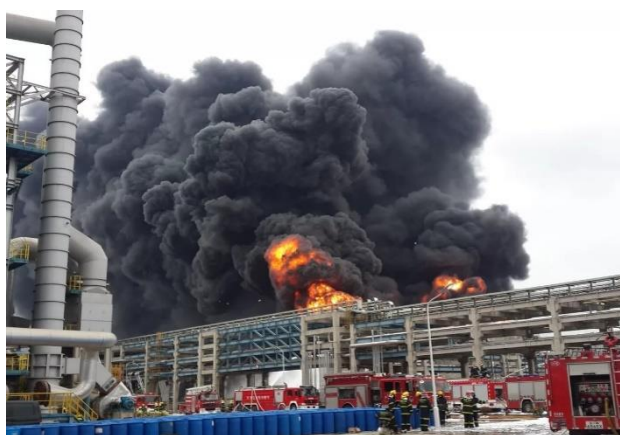
Рис. 1. Пожар на Комсомольском нефтеперерабатывающем заводе
