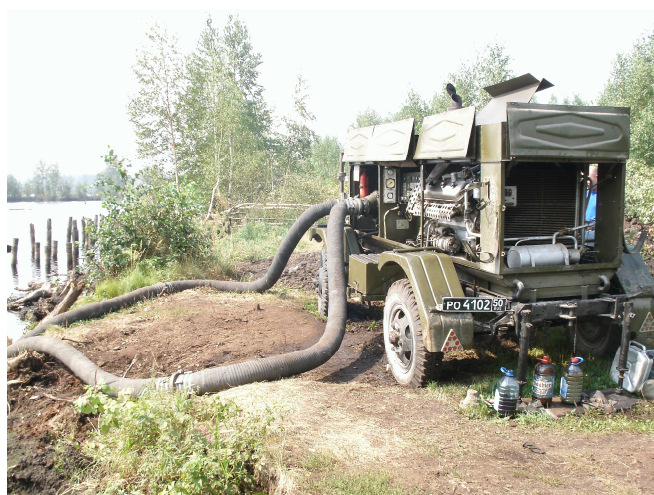
Рис.3 Насосная станция первого подъема
