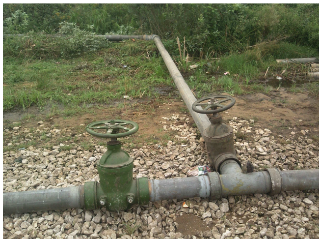
Рис. 5 разветвление трубопроводов с запорной арматурой
