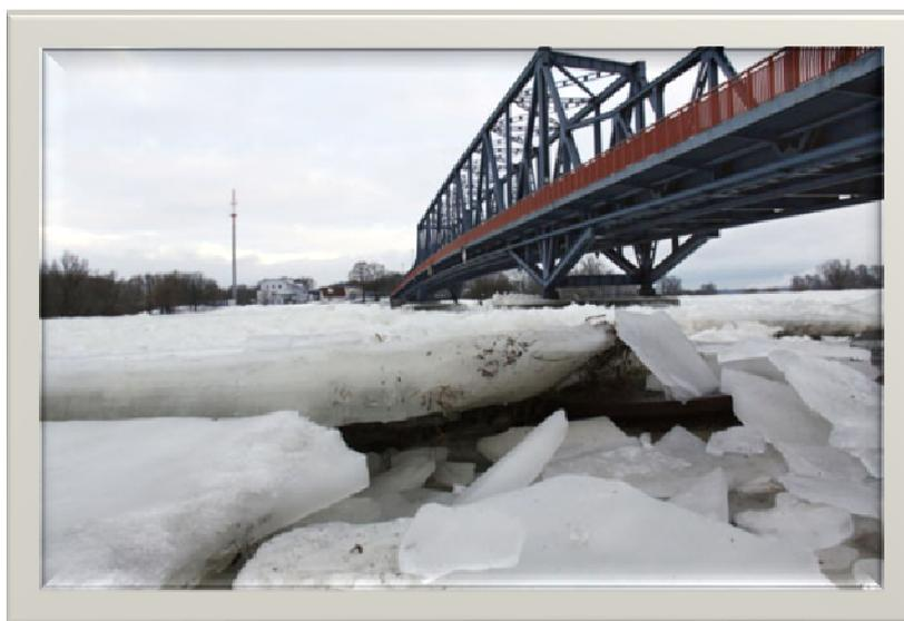
В период ледохода сооружения на реках работают с большим напряжением. Некоторые из них требуют специальных мероприятий для защиты от разрушающего воздействия льда. Одним из способов защиты является взрывной (взрывание ледового массива, ледовых заторов и крупных льдин).
