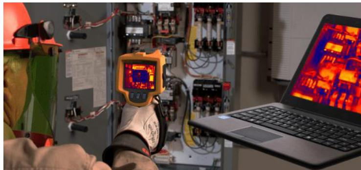
Рисунок 1 – Проведение тепловизионного контроля электрошкафа
