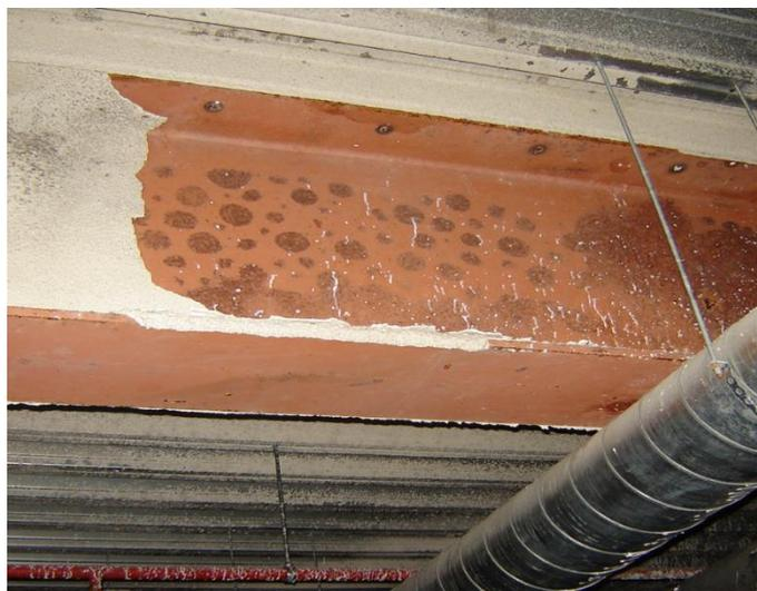
Рисунок 1 – Результат нанесения штукатурного состава на «холодный» металл
