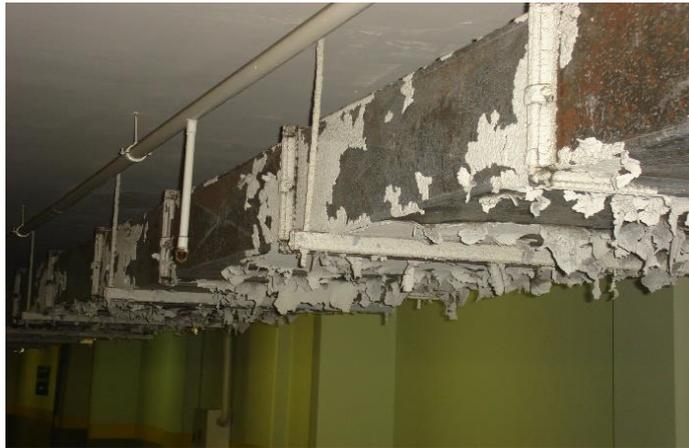
Рисунок 3 – Воздействие вибрации на огнезащитный состав на воздуховоде
