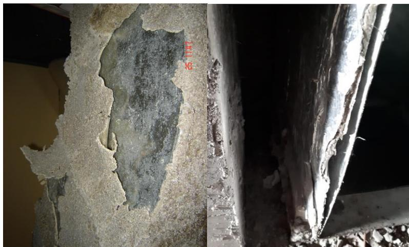
Рисунок 2 – Пренебрежение тщательной подготовки поверхности перед нанесением составов
