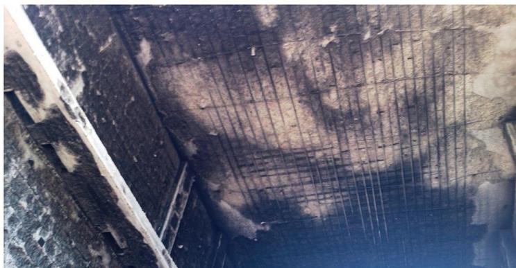
Рисунок 3 – Разрушение монолитного железобетона на перекрытии дворового проезда
