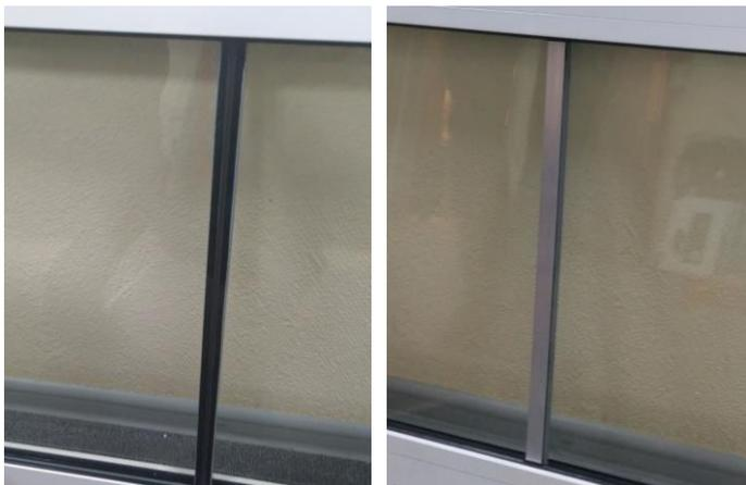
В связи с большим спросом на подобные решения от дизайнеров и архитекторов, ограничивающимся большой ценой на европейские стекла, Компанией ФОТОТЕХ было разработано и испытано решение безрамного стыка стекла в перегородках на железаливных стеклах ЩИТ. Стык стекла может осуществляться с применением специального состава, что делает шов похожим не структурное остекление внешних фасадов, с применением плоского Т-образного профиля шириной
