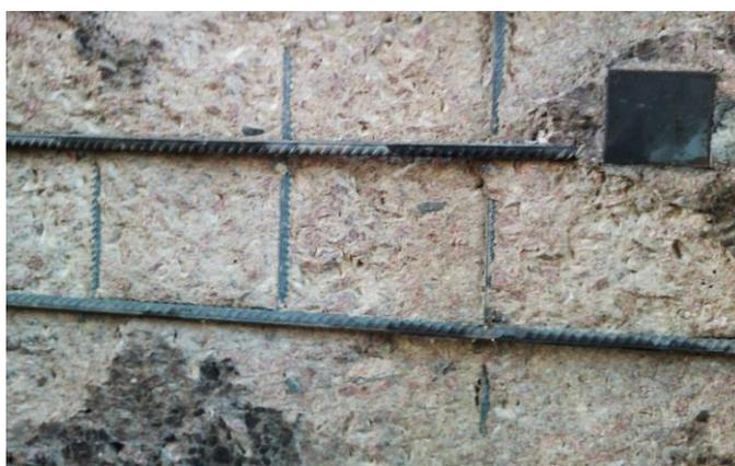
Рисунок 5 – Изменение цвета арматуры в результате воздействия высоких температур
