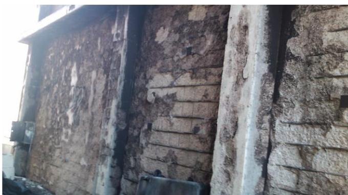
Рисунок 4 – Утрата защитного слоя бетона. Оголенная арматура
